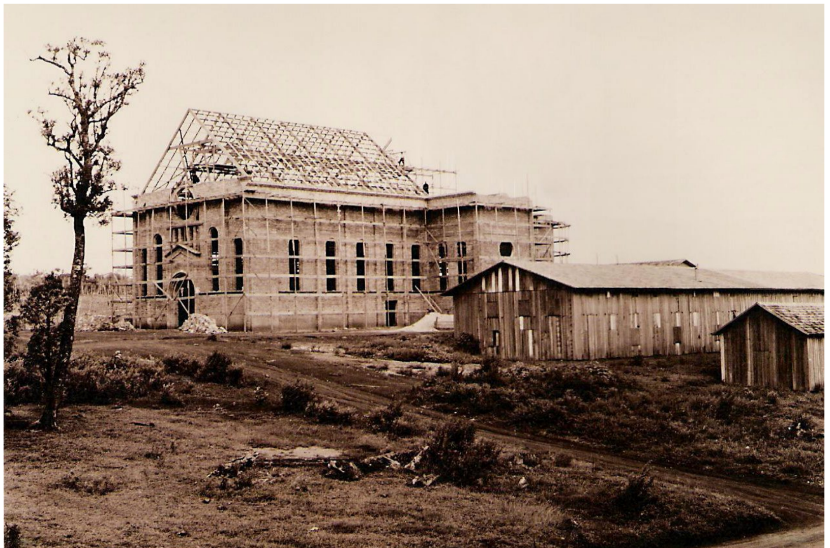
Andamento das obras da Igreja Matriz – 1962.
