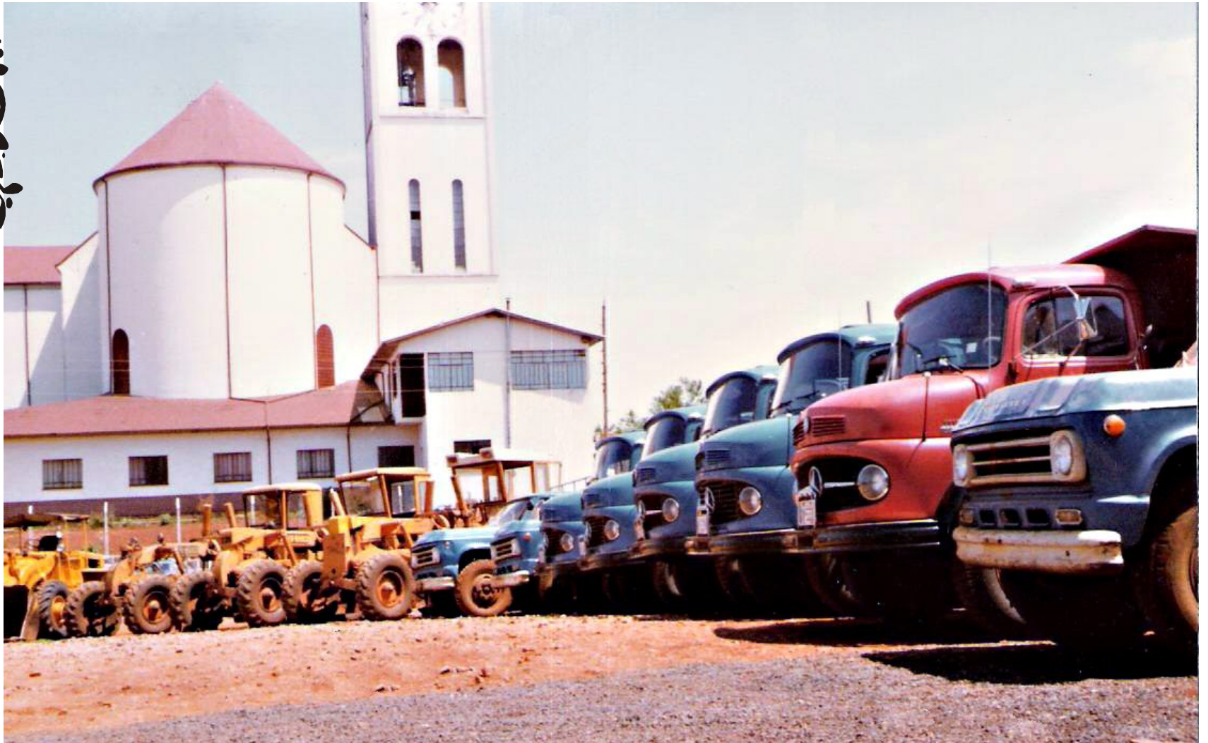
Frota de máquinas e de veículos da administração municipal - 1977/1983 , no pátio do centro comunitário. Acervo de Dionísio Biazussi
