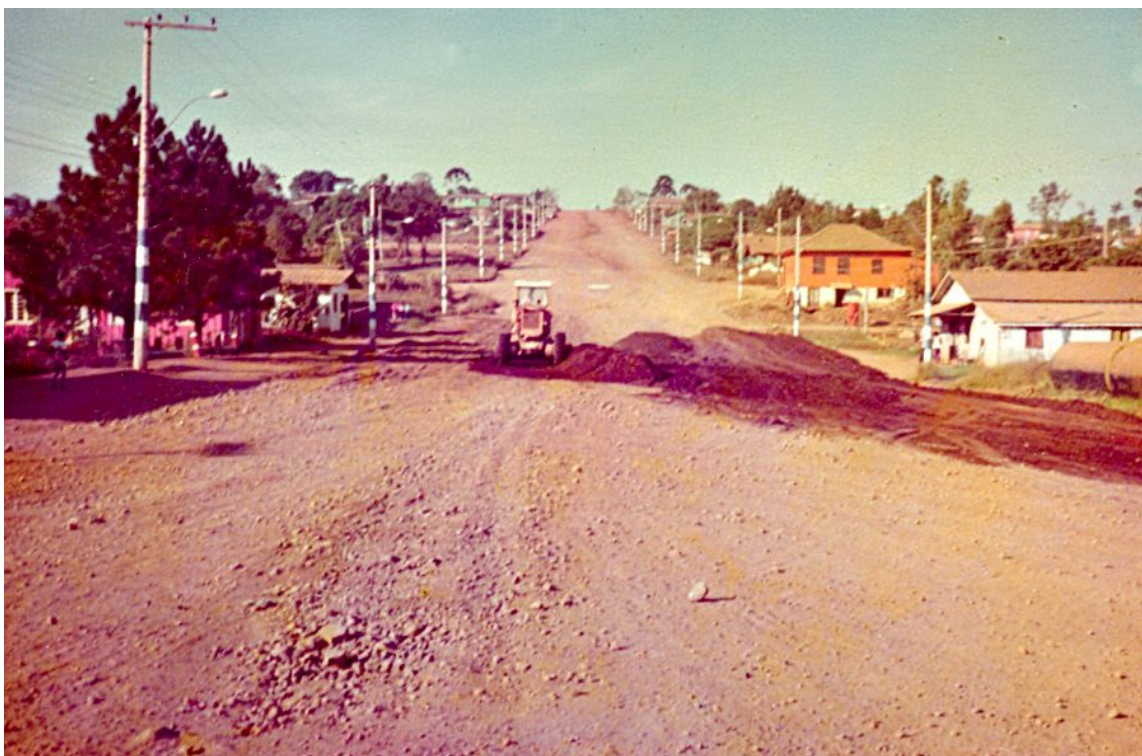
Preparação do leito da Avenida Brasil para a pavimentação com pedras irregulares – 1978. Acervo da prefeitura
