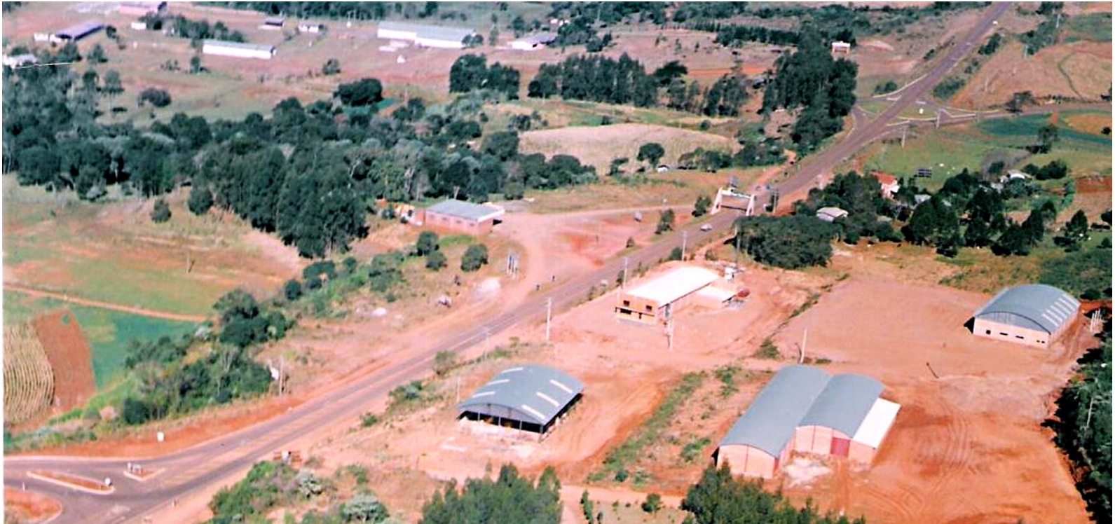
Área Industrial II, Rodovia SC-473. Ao fundo, o parque EFAISLO Acervo da prefeitura de São Lourenço do Oeste
