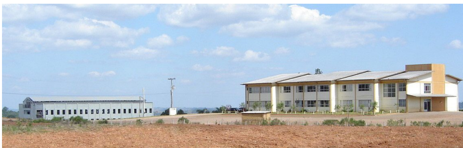
Escola Básica Municipal São Lourenço e Unochapecó. À esquerda, as obras da sede própria do Campus da Unochapecó – 2008
