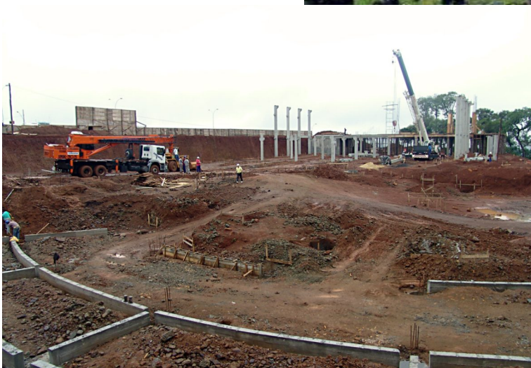
Obras do centro de eventos – 2008 Acervo da prefeitura
