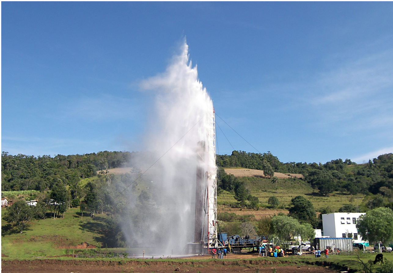
Momento da conclusão da perfuração do poço profundo - 2007
