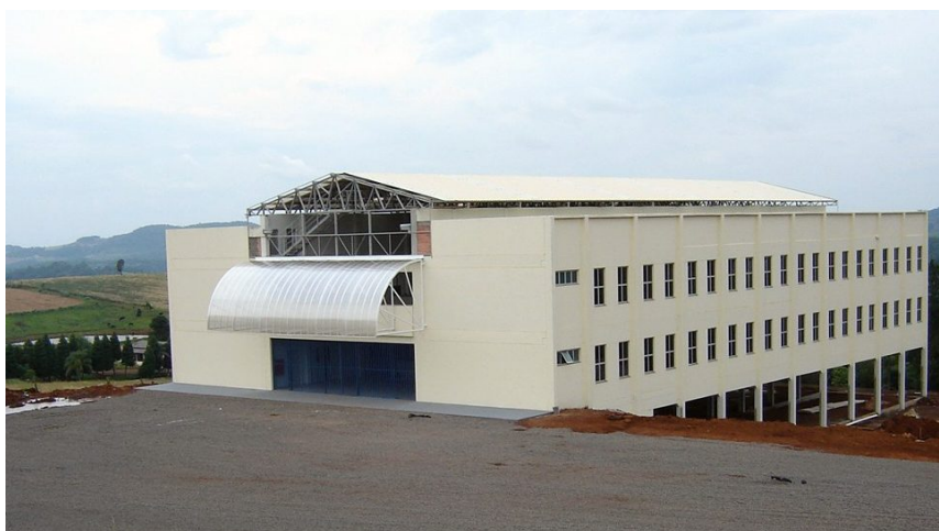
Obras da sede da Unochapecó – 2008 Acervo da Câmara de Vereadores
